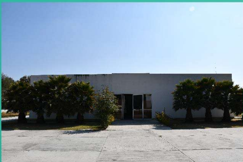
Fachada edificio H
