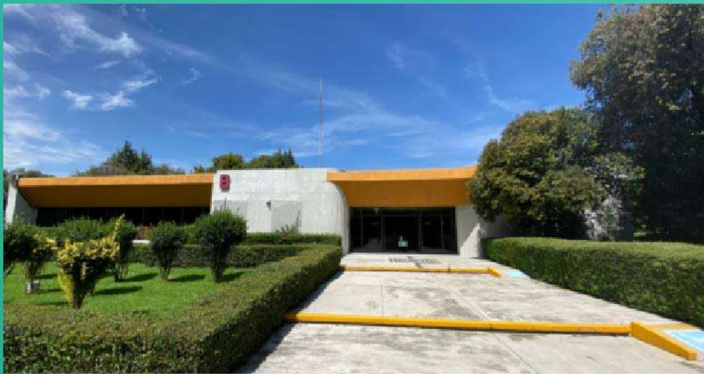
Fachada edificio B
