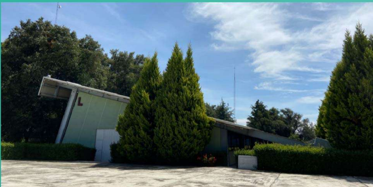
Fachada edificio L
