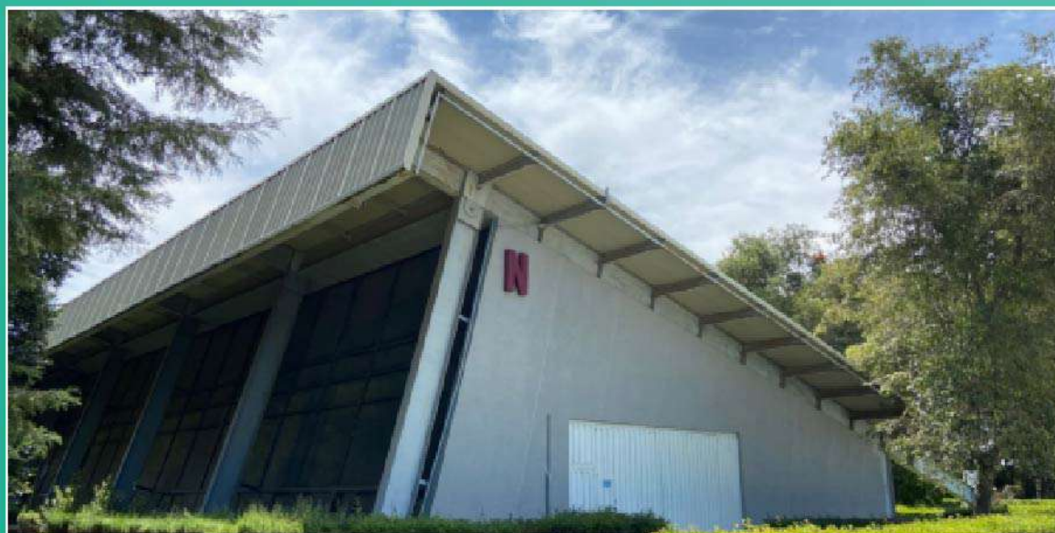
Fachada edificio N
