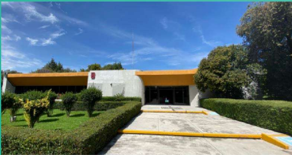
Fachada edificio B
