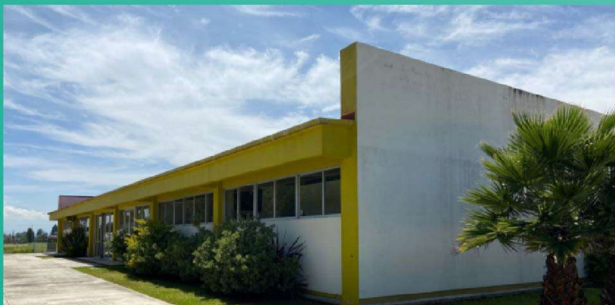
Fachada edificio H
