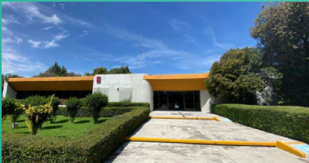
Fachada edificio B
