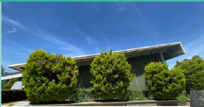
Fachada edificio D
