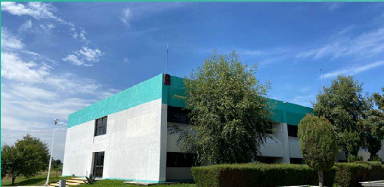
Fachada edificio G
