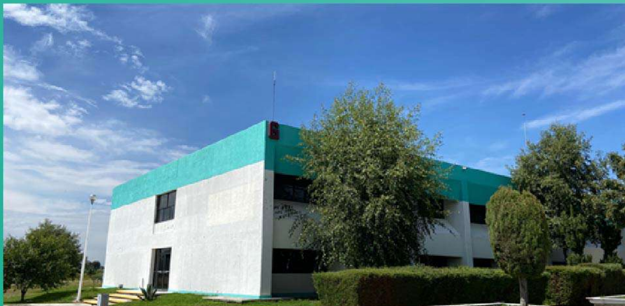
Fachada edificio G
